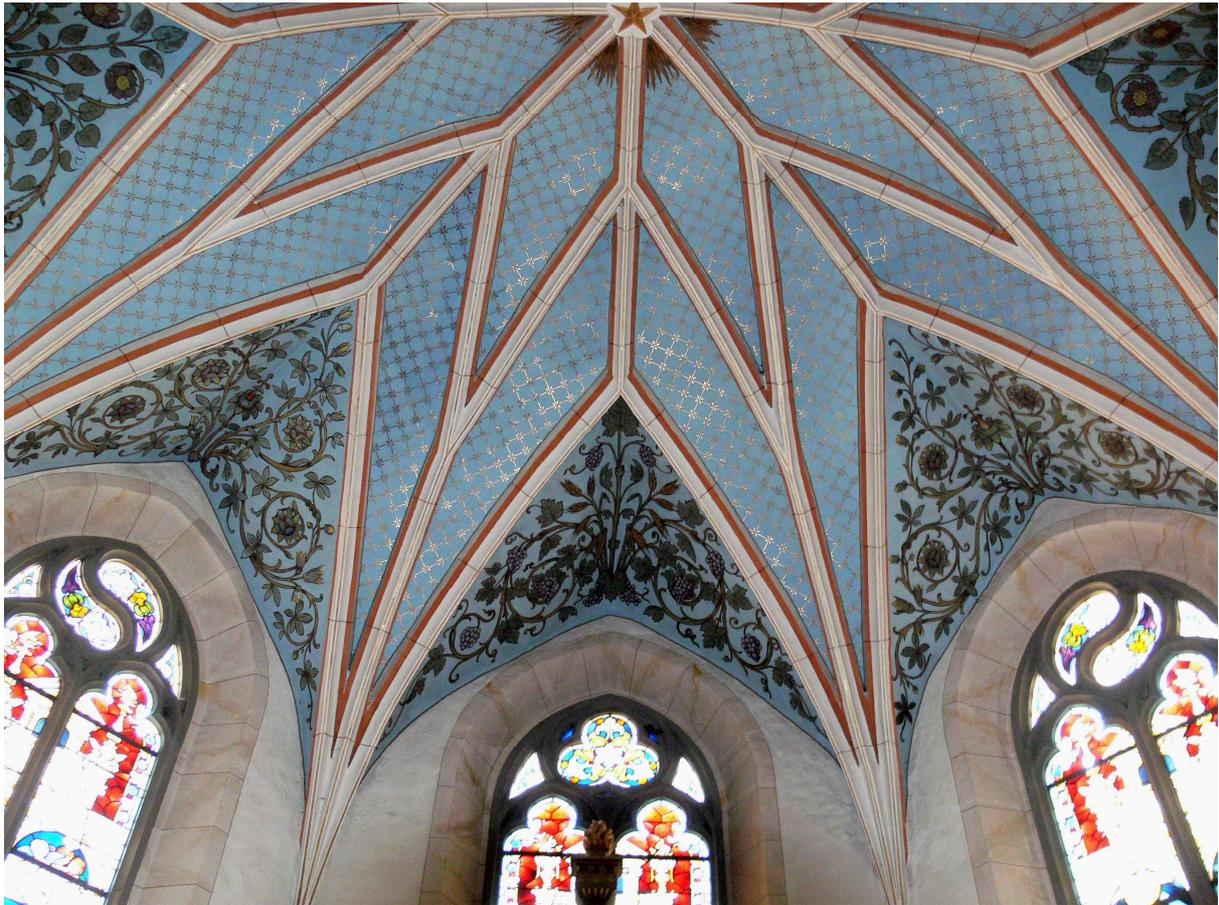
Das Sternengewölbe mit den Kreuzrippen ist ein wichtiger erhaltener Teil der ursprünglichen gotischen Kirche. Die Kreuzrippen tragen die Last der Ziegelgewölbe und übertragen die Last der Decke auf die Außenmauer zwischen den Maßwerkfenstern.
