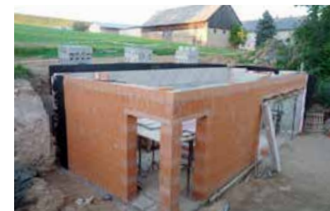
Das erste Stockwerk des Ersatzneubaus steht
